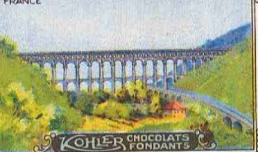
PONT DE ROQUEFAVOUR FRANCE
